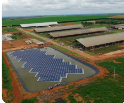
Gerador fotovoltaico rural com estrutura flutuante de 1,01 MWp - MG
