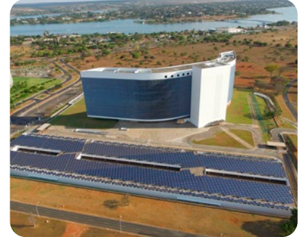
Gerador fotovoltaico para setor público de 304 kWp - DF
