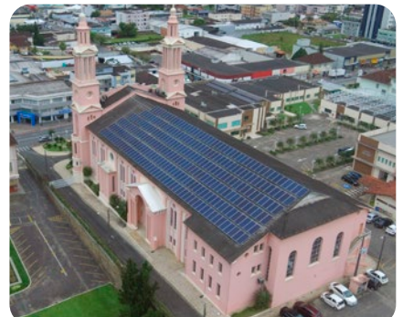
Gerador fotovoltaico para entidades religiosas de 60 kWp - SC
