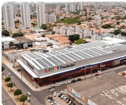
Gerador fotovoltaico comercial de 492 kWp - RN
